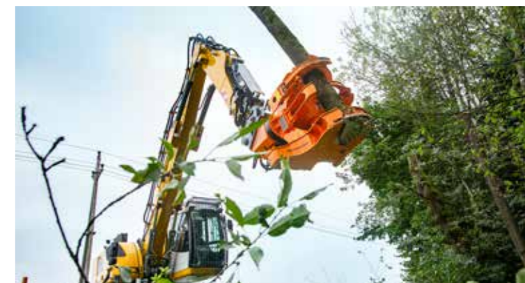
Manutenzione delle reti.
