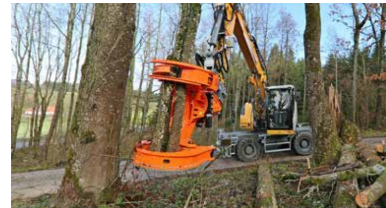
Woodcracker® C nella messa in sicurezza del traffico.
